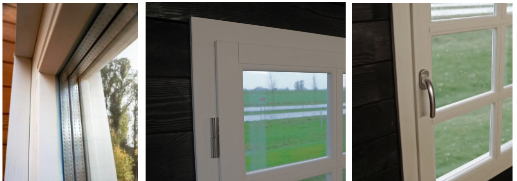
Triple beglazing, standaard scharnier en standaard raamkruk (naar binnen draaiend).
