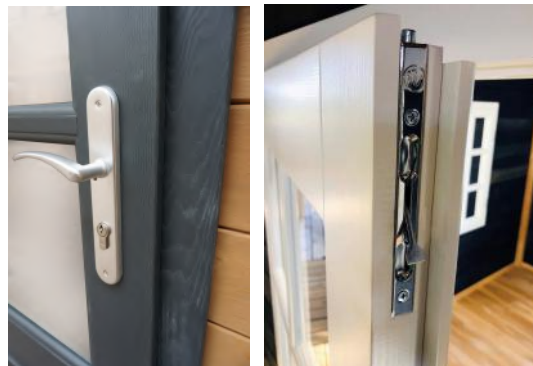
Deurkruk met cilinderslot, boven sluiting dubbele deuren.
